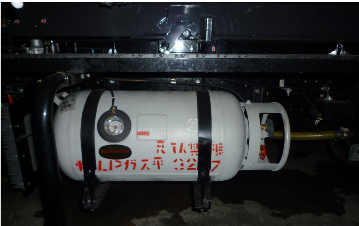
LP ガス燃料タンク
